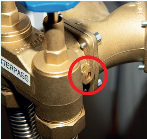
Wenn Sie die Wasserhärte verstellen möchten, können Sie dies an dieser Schraube tun. Drehen Sie die Schraube im Gegenuhrzeigersinn, wird das Wasser härter.
