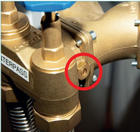
Wenn Sie die Wasserhärte verstellen möchten, können Sie dies an dieser Schraube tun. Drehen Sie die Schraube im Gegenuhrzeigersinn, wird das Wasser härter. Drehen Sie im Uhrzeigersinn, wird das Wasser weicher. Drehen Sie immer nur ganz wenig, lassen Sie dann das Wasser rund 3 Minuten laufen und messen Sie die Wasserhärte. Den Vorgang dann so lange wiederholen, bis Sie die gewünschte Wasserhärte haben.
